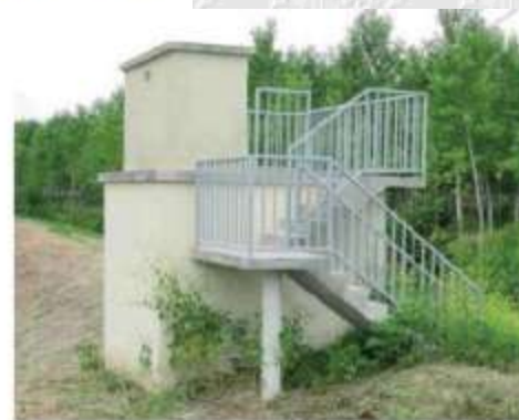
Figura 8. Transformador eléctrico sobrelevado situado en la zona inundable del Río Garona.
